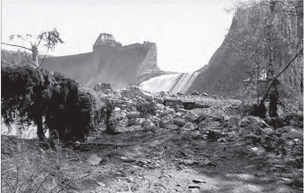
Fig. 1.41 Brecha en el dique Möhne, en Alemania, varias horas después de bombardeado en 1943.
